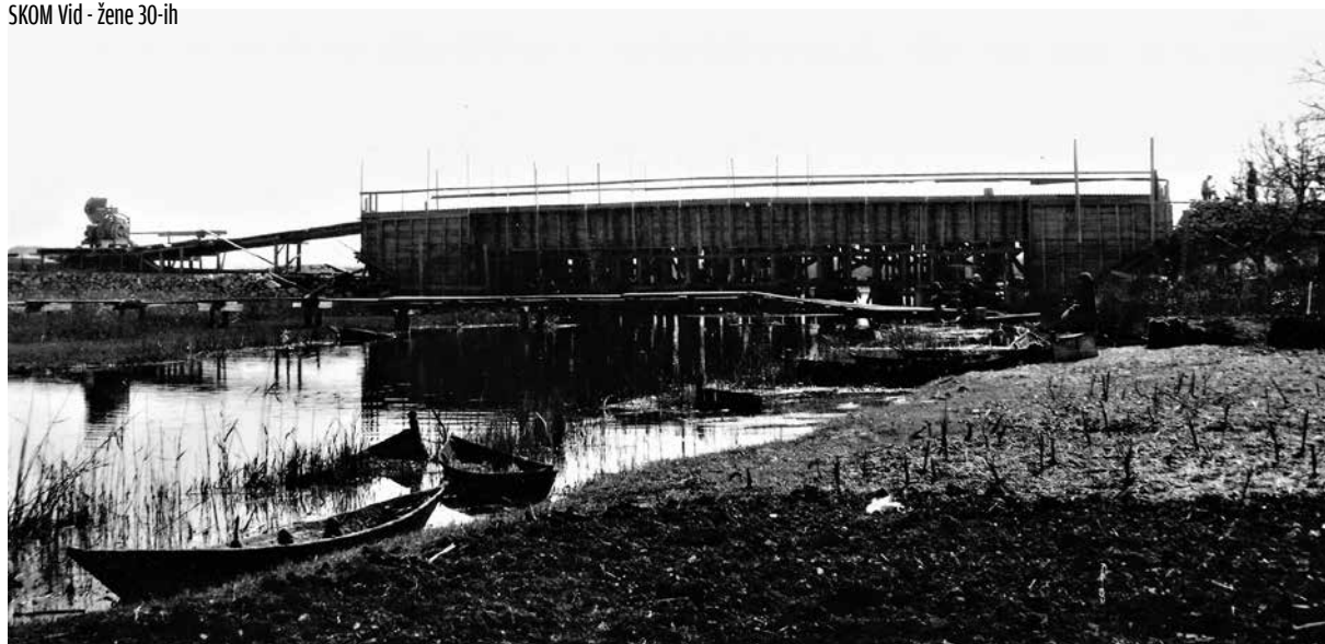
Gradnja mosta u Vidu
